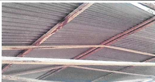
SUSTITUCIÓN DE ESTRUCTURA DE MADERA, POR METAL
