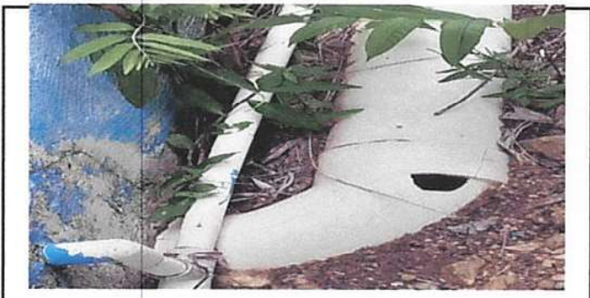
SUSTITUCIÓN DE TUBERIA LINEA PRINCIPAL
