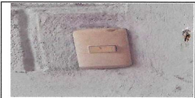
SUSTITUCIÓN DE INTERRUPTOR DOBLE
