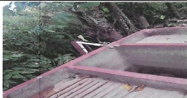
SUSTITUCIÓN DE PILA DE CEMENTO DE 2 LAVADEROS
