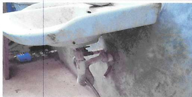
SUSTITUCIÓN DE LAVAMANOS
