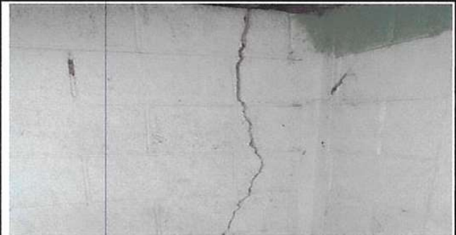
REPARACIÓN DE MURO DE CONTENCIÓN
