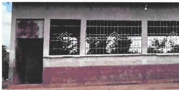
PINTURA EN MURO EXTERIOR E INTERIOR
