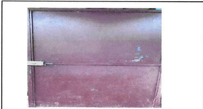
SUSTITUCIÓN DE CHAPAS
