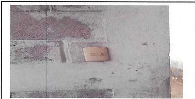
SUSTITUCIÓN DE TOMACORRIENTES DOBLES
