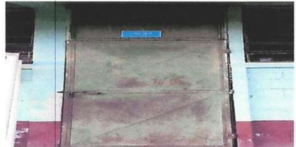
SUSTITUCIÓN DE PUERTA
