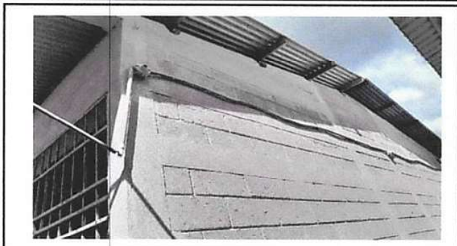
SUSTITUCIÓN DE CABLEADO PRINCIPAL
