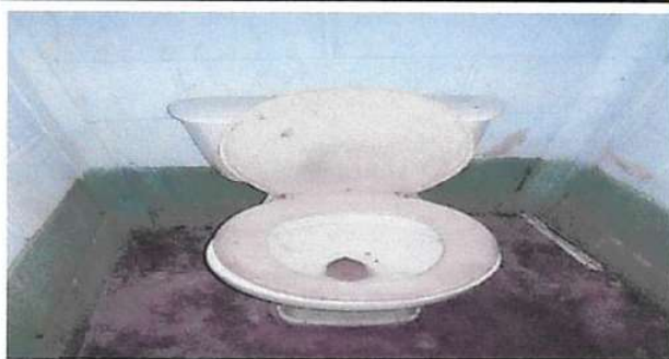
SUSTITUCIÓN DE ACCESORIOS PARA INODORO
