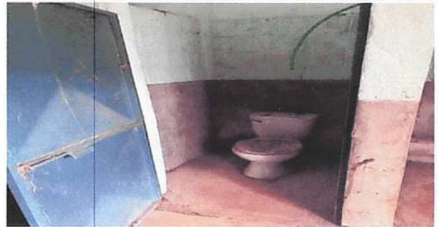
MANTENIMIENTO EN PUERTA EN SERVICIO SANITARIO
