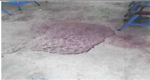
SUSTITUCIÓN DE PISO DE TORTA DE CEMENTO
