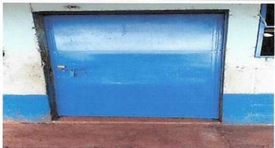
Foto 3 : Foto 17: Mantenimiento a estructura (lijado, cambio de tubo , cepillado, sujeciones, aplicación de pintura)
