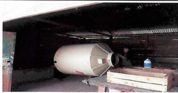
Foto 7 : Sustitución de deposito de agua 1700 lt
