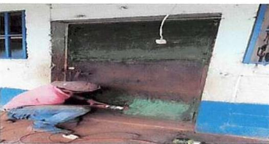
Foto 3 : Foto 17: Mantenimiento a estructura (lijado, cambio de tubo , cepillado, sujeciones, aplicación de pintura)
