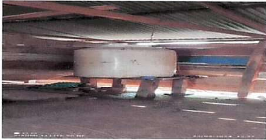
Foto 7 : Sustitución de deposito de agua 1700 lt
