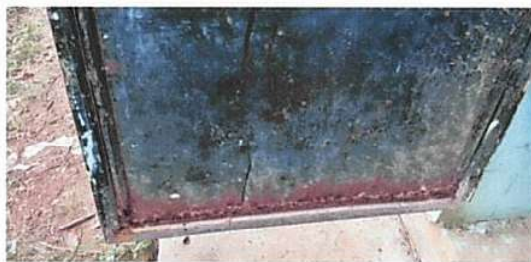
Foto 5 : Sustitución de puerta
