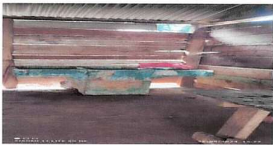
Foto 9 : Sustitución de pila de cemento de dos lavadero
