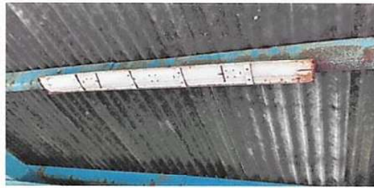
Foto 2: Sustitucion de estructura de soporte de metal, por metal
