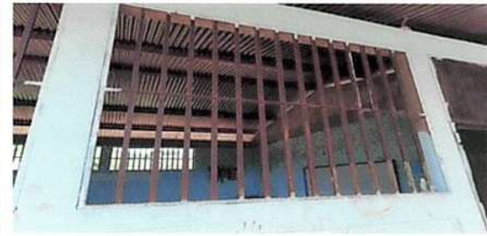
Foto 6 : Mantenimiento a balcones de metal
