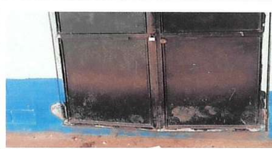
Foto 4 : Sustitución de chapa
