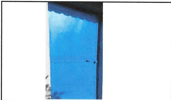
Foto 3: Sustitución de puerta
