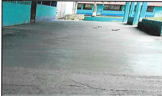
Foto 1: Sustitución de piso de torta de concreto
