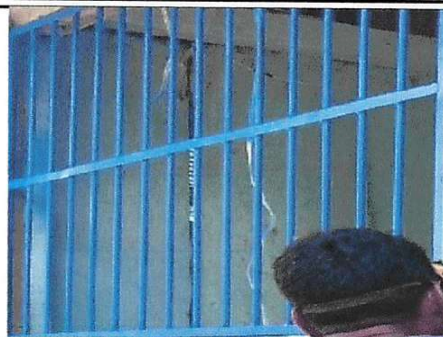
Foto 2: Sustitución de balcones de metal
