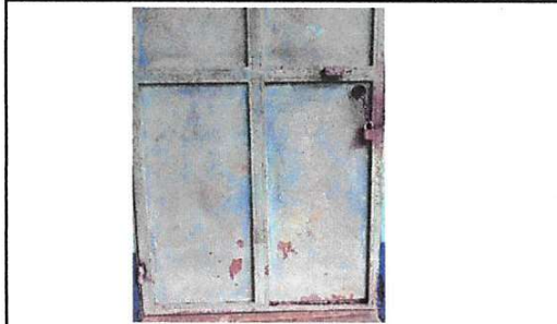
Foto 3: Sustitución de puerta
