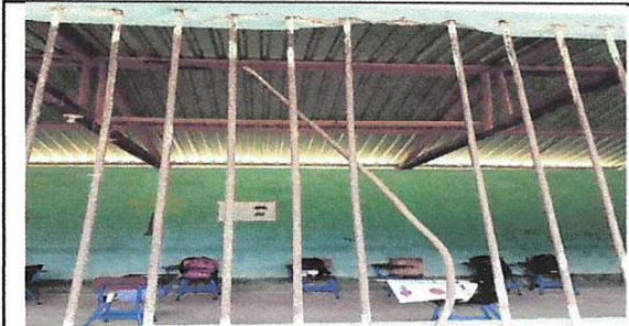
Foto 2: Sustitución de balcones de metal
