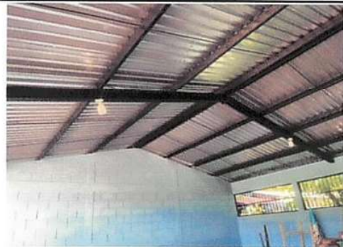
Foto 4: INSTALACIÓN DE CABLEADO ELÉCTRICO
