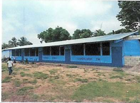
Foto1: TECHADO DE LAS 4 AULAS ESCOLARES
