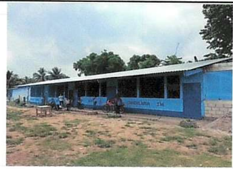
Foto 2: PINTURA INTERNA Y EXTERNA DEL ESTABLECIMIENTO.
