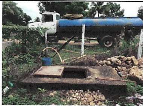
Foto 5: FOSA SEPTICA LIMPIA.
