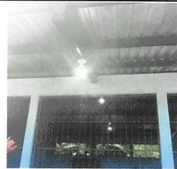
Foto 6: COLOCACIÓN DE BOMBILLAS NUEVAS
