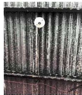
Foto 6: NECESITA REPARACIÓN LAS BOMBILLAS
