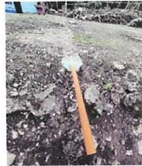
Foto 10: SUSTITUCION DE TUBERIA LINEA PRINCIPAL
