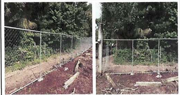
Foto 1: MANTENIMIENTO DE TUBO HG Y MALLA GALVANIZADA
