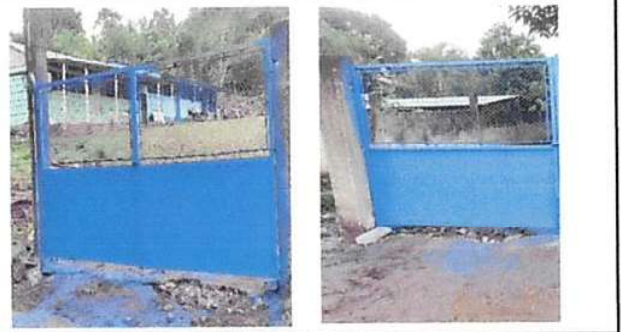
Foto 2: SUSTITUCION DE PORTON DE METAL
