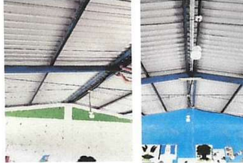
Foto 8: SUSTITUCION DUCTO ELECTRICO MAS ACCESORIOS
