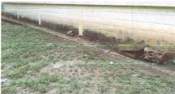
Foto 5: pintura de exteriores.
