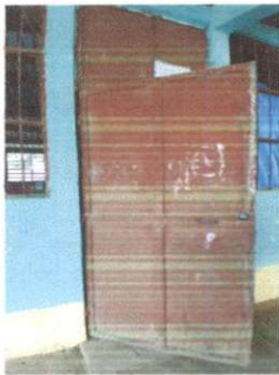
Foto 3: fabricación e instalación de puertas de metal en módulos.
