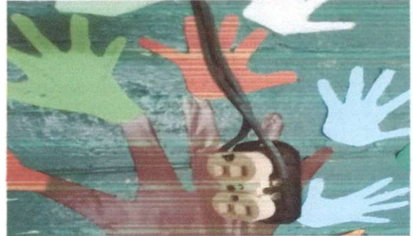
Foto 2: sustitución de toma corriente.
