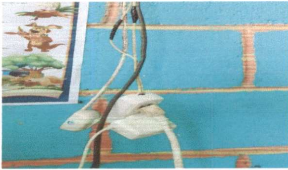
Foto 3: sustitución de interruptores simples.
