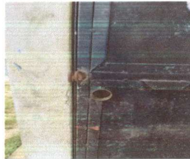
Foto 4: sustitución de chapa.
