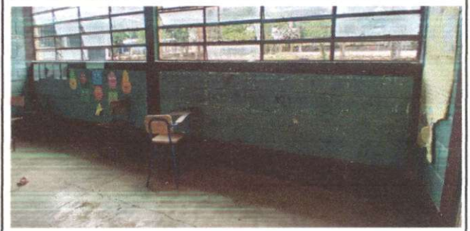
Foto 6: pintura de interiores.
