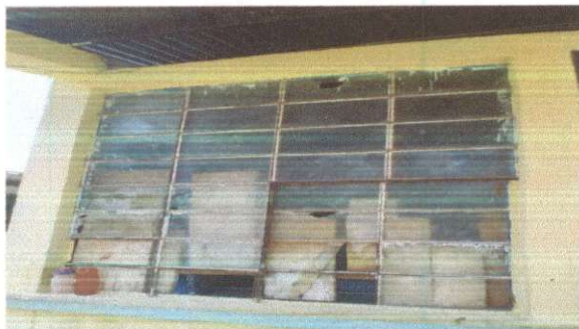
Foto 1: mantenimiento a marcos de aluminio mill finish.
