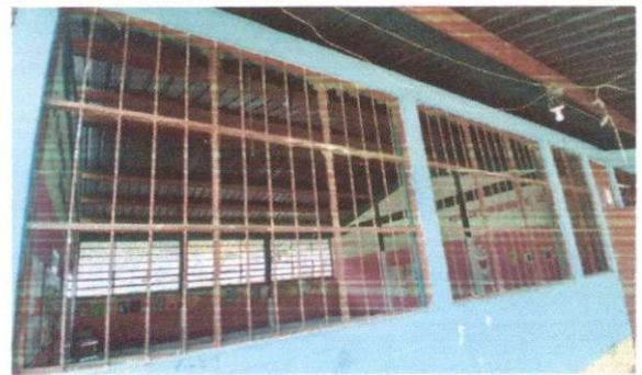
Foto 2: mantenimiento de balcones de metal.
