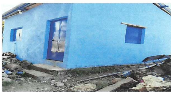
Foto 3: REPARACION DE REPELLO Y CERNIDO DE PAREDES: REPELLO EN MURO
