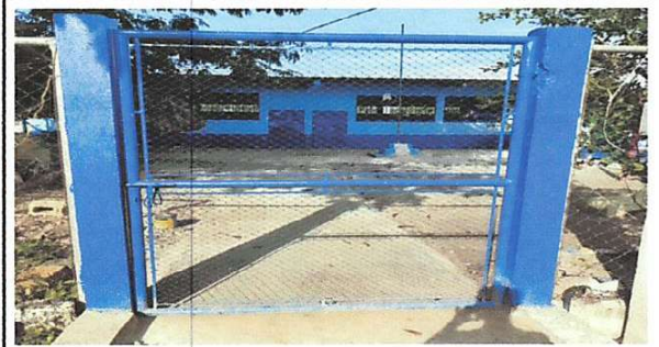
Foto 4: MANTENIMIENTO A PORTONES: MANTENIMIENTO A PORTONES DE METAL
