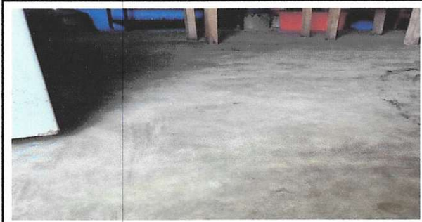
Foto 6: PISO: SUSTITUCION DE PISO DE CEMENTO LIQUIDO
