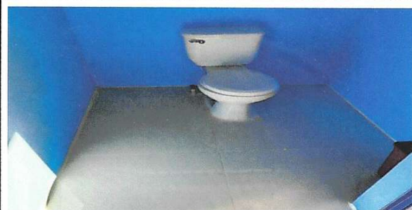
Foto7: SERVICIO SANITARIO Y SUSN ACCESORIOS: SUSTITUCION DE INODORO
