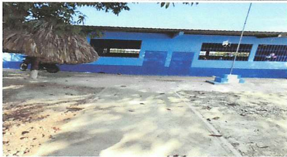
Foto1: PINTURA EN MUROS EXTERIOR E INTERIOR
