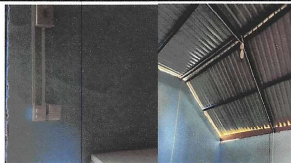
Foto 10: REPARACION DEL SISTEMA ELECTRICO, SUSTITUCIÓN DE DUCTO ELECTRICO
