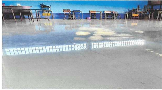
Foto1: PISOA. SUSTITUCION DE PISO CERAMICO
