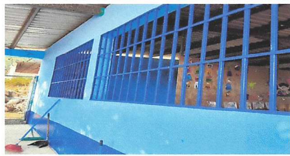
Foto 3: VENTANAS: MANTENIMIENTO A ESTRUCTURA DE METAL DE VENTANAS
