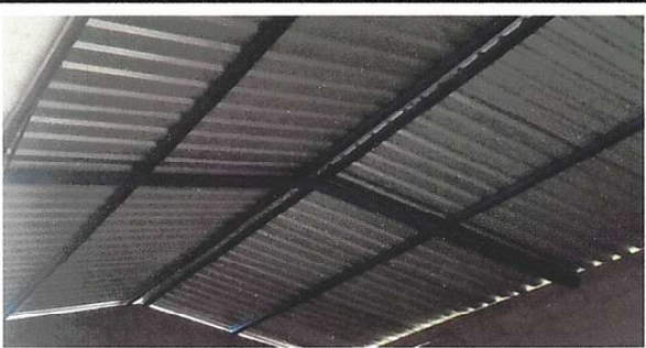
Foto 5: CUBIERTA DE LAMINA: SUSTITUCIÓN DE LAMINA POR LAMINA TROQUELADA ALUZINC CALIBRE 26
