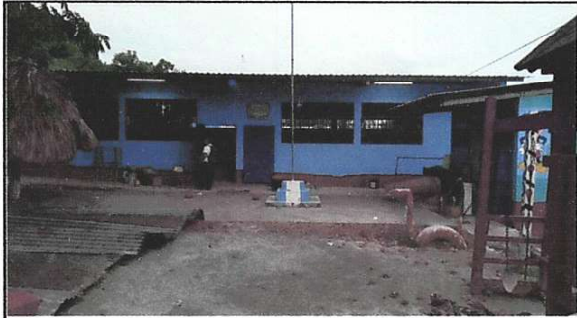
Foto1: PINTURA EN MUROS EXTERIOR E INTERIOR
