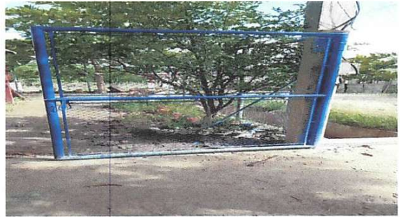
Foto 4: MANTENIMIENTO A PORTONES: MANTENIMIENTO A PORTONES DE METAL
