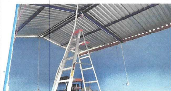
Foto 10: REPARACIÓN DEL SISTEMA ELECTRICO: SUSTITUCIÓN DE DUCTO ELECTRICO
