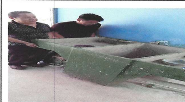
Foto 2: REPARACION DE COCINA: SUSTITUCIÓN DE PILA DE CEMENTO
