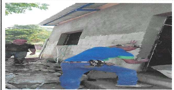
Foto 3: REPARACION DE REPELLO Y CERNIDO DE PAREDES: REPELLO EN MURO
