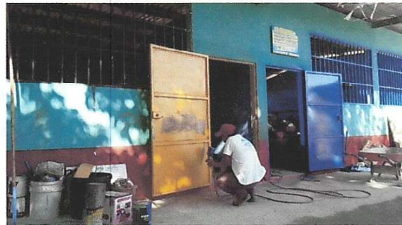
Foto 2: PUERTAS DE METAL: MANTENIMIENTO A ESTRUCTURA
