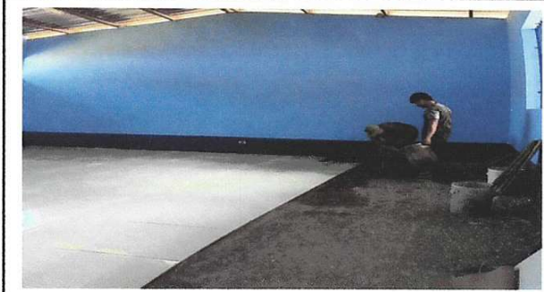
Foto1: PISOA. SUSTITUCION DE PISO CERAMICO
