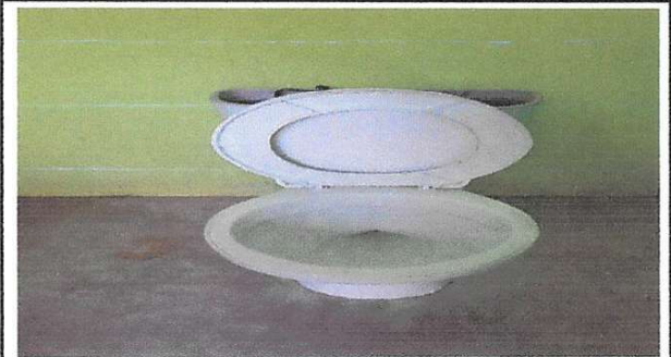
Foto 7: SERVICIO SANITARIO Y SUS ACCESORIOS. SUSTITUCIÓN DE INODORO
