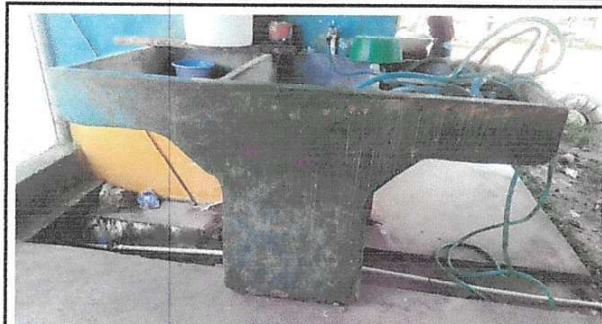
Foto 2: REPARACIÓN DE COCINA: SUSTITUCIÓN DE PILA DE CEMENTO DE DOS LAVADEROS
