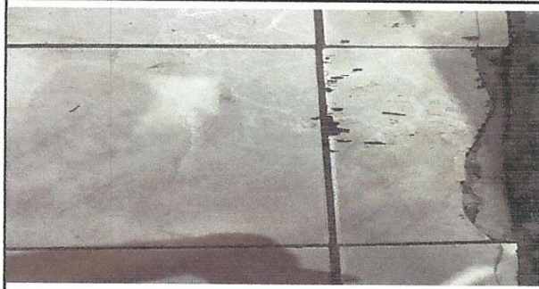
Foto1: PISO: SUSTITUCIÓN DE PISO CERAMICO
