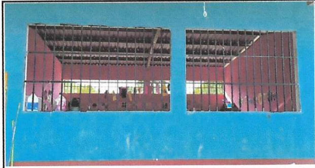
Foto 3: VENTANAS: MANTENIMIENTO DE ESTRUCTRA DE METAL DE VENTANAS
