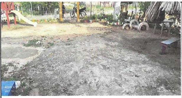
Foto 9: LOSA DE PATIO. REPARACION DE PLANCHA DE CONCRETO DE PATIO
