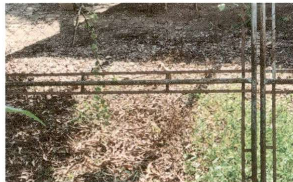
Foto 4: Sustrucción de porton de metal
