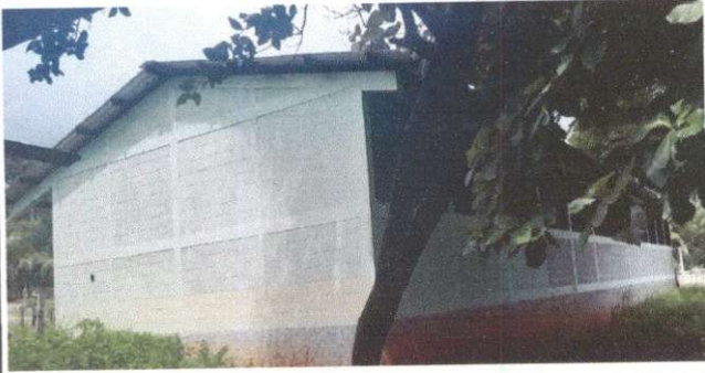
Foto 7: Pinturas en muros exterior e interior
