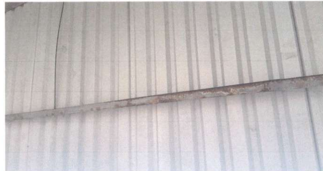
Foto 2: Sustrucción de estructura de metal por metal
