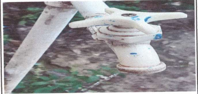
Foto 8: Sustitución de llave de chorro
