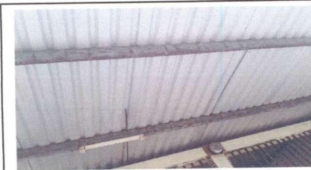
Foto 9: Sustitución de focos ahorradores
