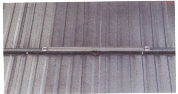
Foto 10: Sustitución de plafoneras
