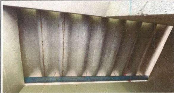
Foto1:Sustitución de lamina, por lamina troquelada aluzinc calibre 26 modulo de aulas modulo baños
