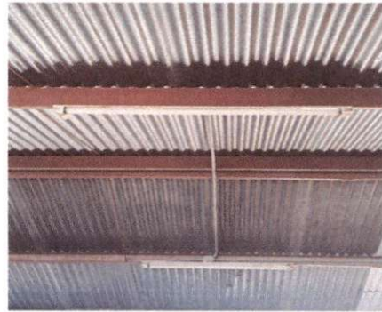
Foto 4: Reparación de sistema eléctrico
