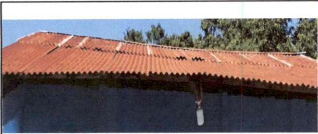
Foto 1: Sustitución de lámina, por lámina troquelada aluzic calibre 26
