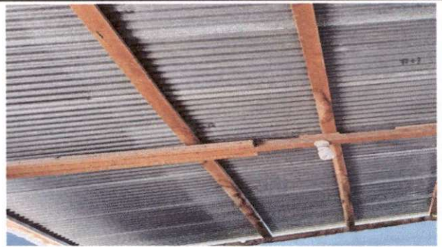
Foto2: Sustitución de soporte de madera, por metal
