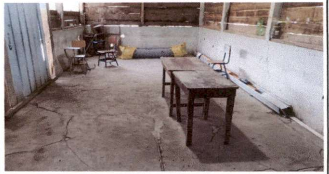
Foto 8: Reparación piso torta de concreto
