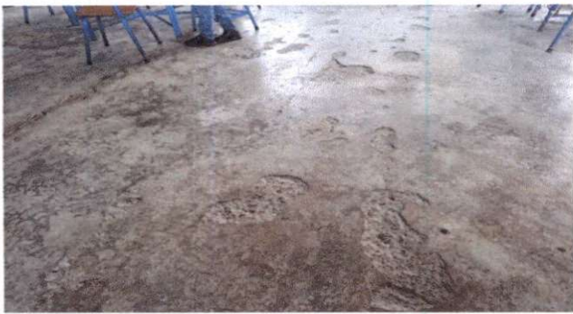
Foto 7: Reparación de piso líquido
