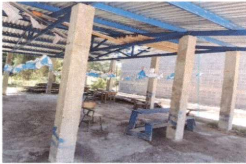
Foto3: Repello en muros
