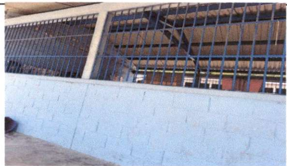
Foto 6: Pintura exterior e interior
