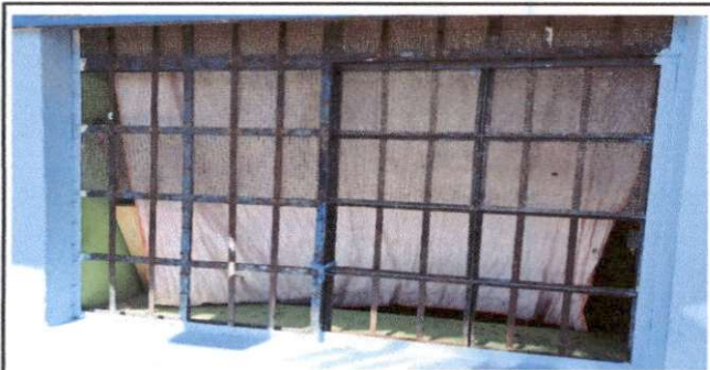
Foto 5: Sustitución de balcones de metal
