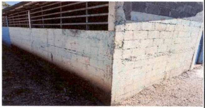
Foto 10: Reparación de repello y cernido en muro y paredes
