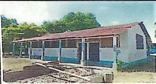
SUSTITUCION DE LAMINA, POR LAMINA TROQUELADA ALUZINC CALIBRE 26
