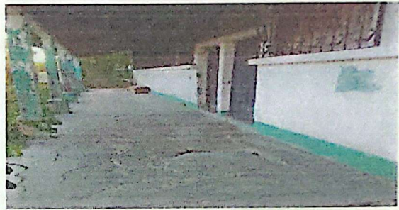
REPARACION DE PISO DE CEMENTO LIQUIDO
