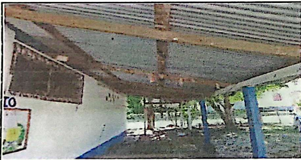
PINTURA EN MUROS EXTERIORES E INTERIORES
