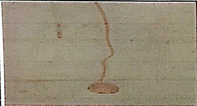
SUSTITUCIÓN DE CABLEADO ELECTRICO
