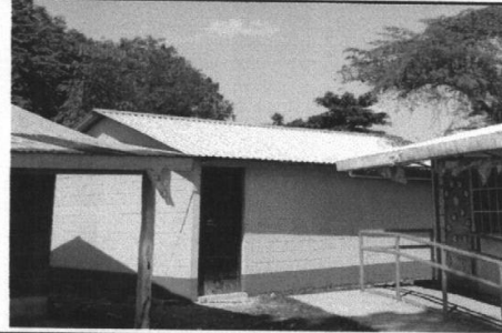
Foto 2: Sustitución de lámina, por lámina troquelada aluzinc calibre 26
