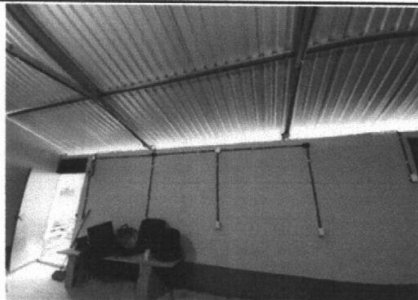
Foto 3: Sustitución de estructura de soporte de madera, por metal
