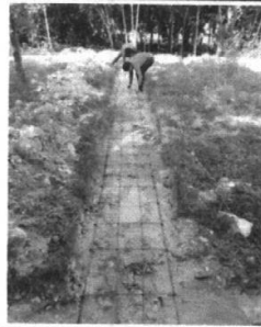
Foto 7: Reparación de cuneta de concreto
