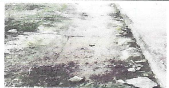
REPARACIÓN DE CUNETAS DE CONCRETO
