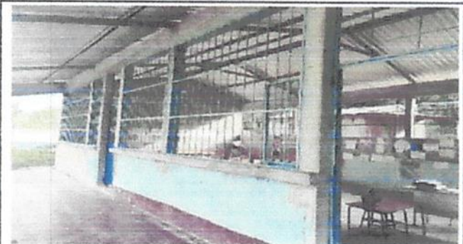
FABRICACIÓN E INSTALACIÓN DE BALCON DE METAL EN VENTANA
