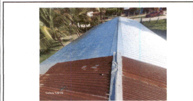
Foto 3: Techo de lamina terminado
