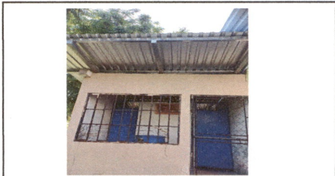
Foto 2: estructura de metal lado fuera del baño
