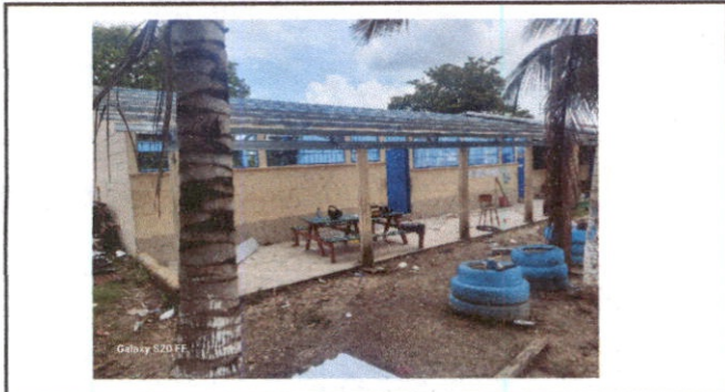
Foto 3: Estructura de metal de las 2 aulas
