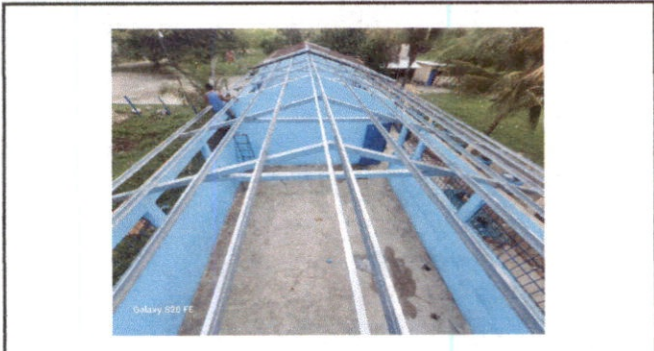
Foto 1: Techo de las 2 aulas
