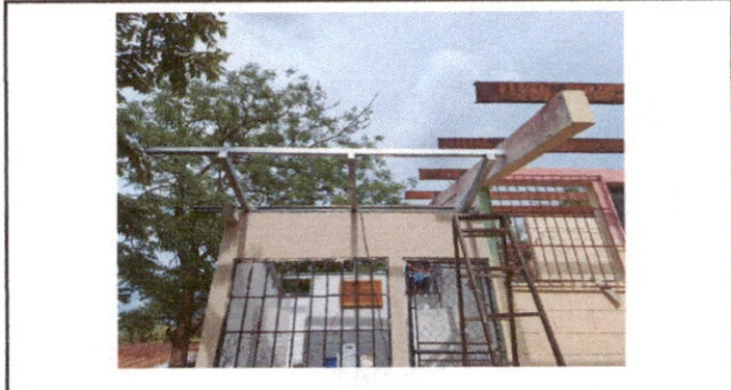
Foto 2: estructura de metal del techo del baño
