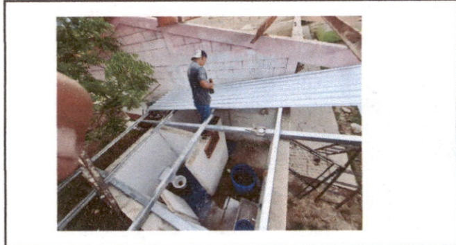
Foto 4: Colocación de la lamina en el techo del baño
