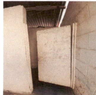
Foto 5: puertas del baño
