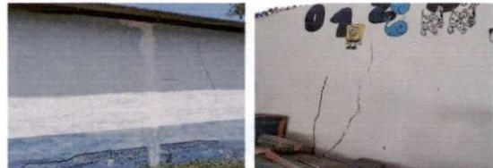
Foto 6: Sellado de grietas y fisuras en muros.
