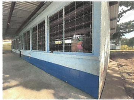
Foto 4: Pintura en muros exteriores e interiores
