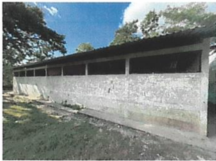
Foto 3: Mantenimiento de balcones de metal
