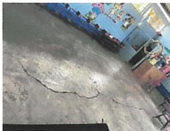
Foto 5: Reparación de piso de torta de concreto en dos aulas
