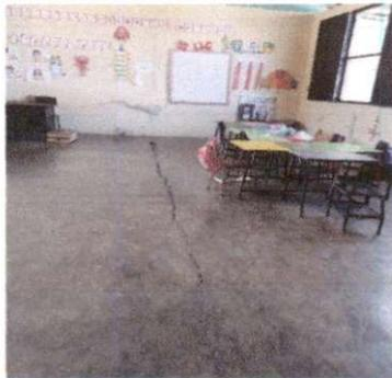
Foto 9: Reparación de piso de cemento liquido
