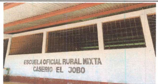
PINTURA EN MUROS EXTERIORES E INTERIORES
