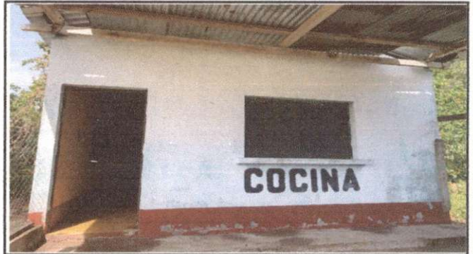
CAMBIO DE CUBIERTA DE LAMINA
