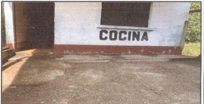
Sustitución de piso de cemento liquido
