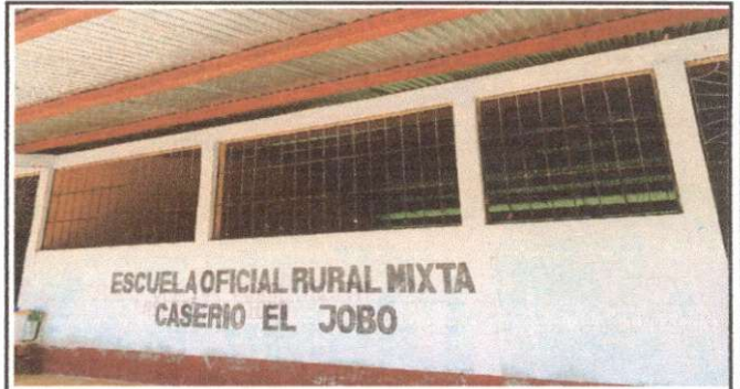
MANTENIMIENTO A BALCONES DE METAL
