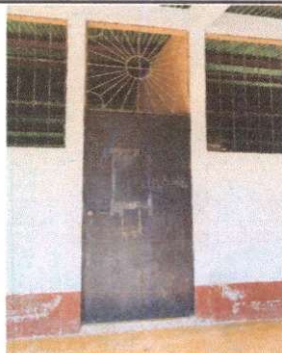
Mantenimiento a estructura (lijado, cambio de tubo , cepillado, sujeciones, aplicación de pintura)
