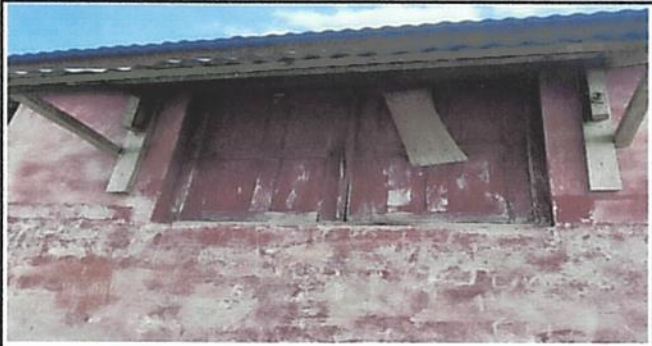
SUSTITUCION DE VENTANA DE MADERA POR METAL
