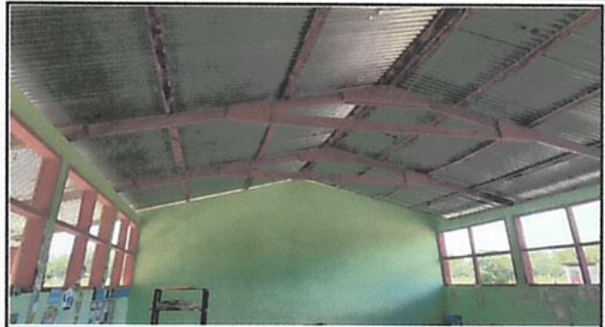
CAMBIO DE CUBIERTA DE LAMINA
