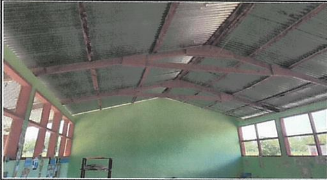
SUSTITUCIÓN DE ESTRUCTURA DE SOPORTE DE MADERA POR METAL
