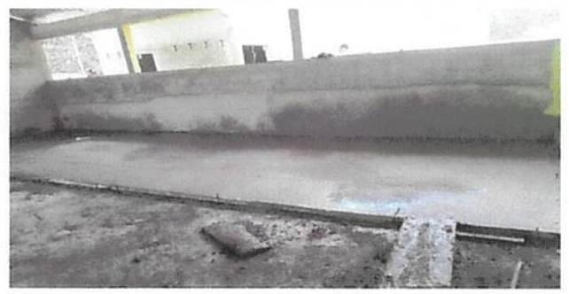
SUSTITUCIÓN DE PISO DE CEMENTO LIQUIDO
