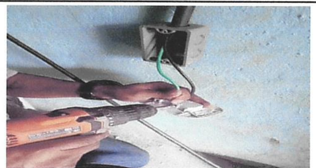
SUSTITUCIÓN DE TOMACORRIENTES DOBLES
