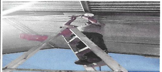
SUSTITUCIÓN DE PLAFONERAS
