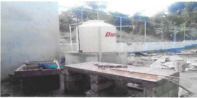
SUSTITUCIÓN A DEPOSITO DE AGUA DE 1,700 LITROS
