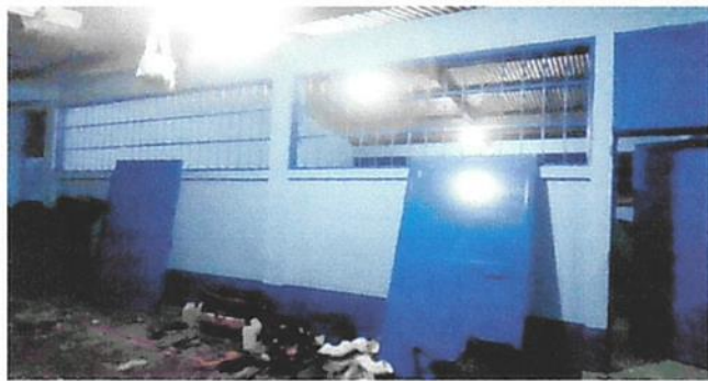
SUSTITUCIÓN DE PUERTA
