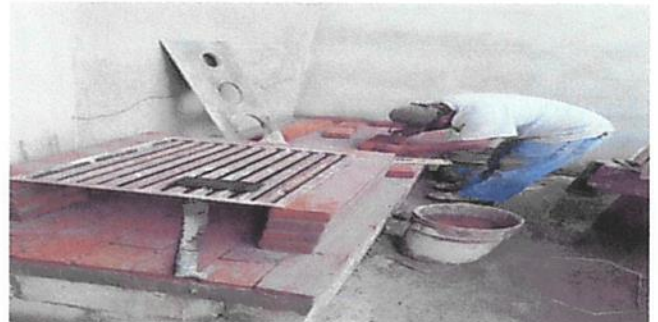
MANTENIMIENTO A ESTUFA RURAL
