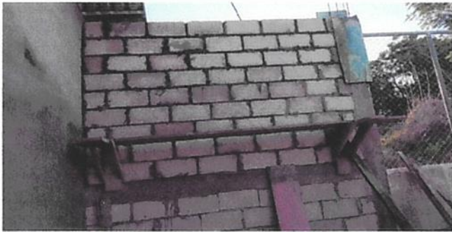
REPARACIÓN DE MURO DE CONTENCIÓN
