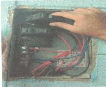
Figura 4: Instalación de tablero y flipones
