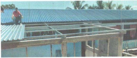
Figura 1: Sustitución de lámina, por lámina troquelada aluzinc calibre 26
