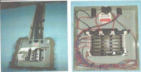
Figura 5: Sustitución de flipones
