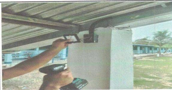
Figura 11: Sustitución de tomacorrientes dobles
