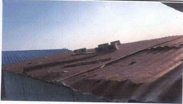
Figura 1: Sustitución de lámina, por lámina troquelada aluzinc calibre 26
