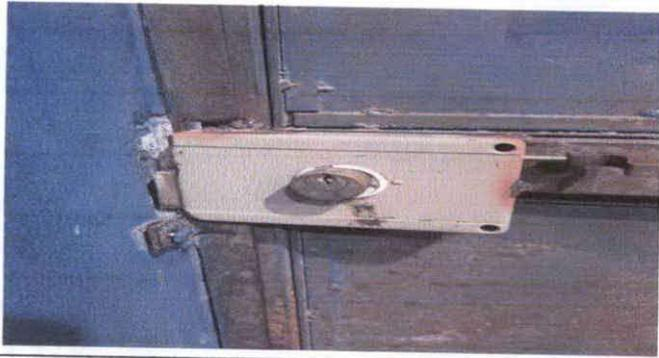
Figura 3: Sustitución de chapa
