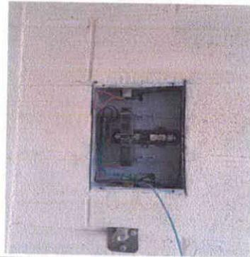
Figura 4: Instalación de tablero y flipones
