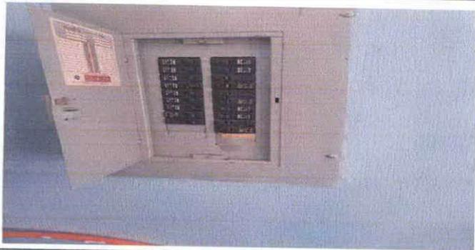
Figura 5: Sustitución de flipones
