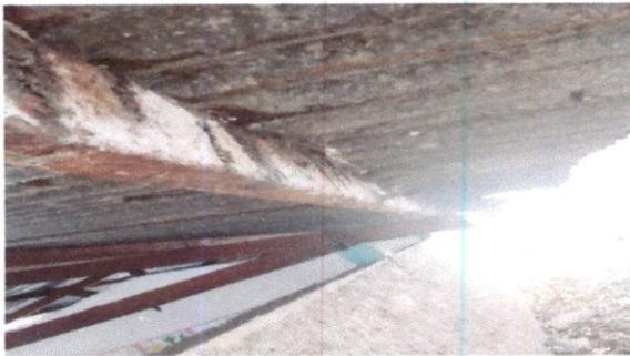
Foto 3: Estructuras dañadas por el óxido
