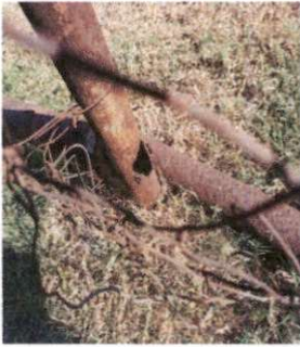
Foto1: SUSTITUCION DE TUBO HG Y MALLA GALVANIZADA
