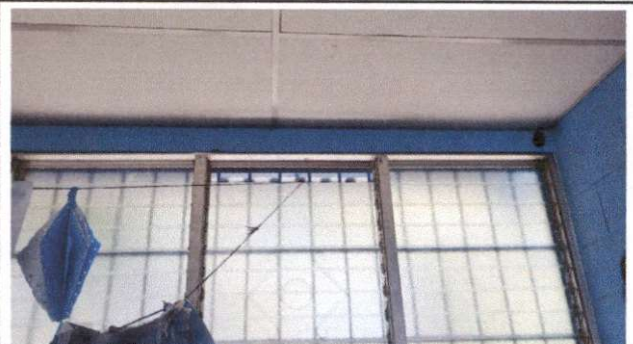
Foto 6: Sustitución de estructura de metal de ventana / fabricación e instalación de ventana- balcon de metal
