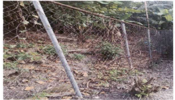
Foto 2: SUSTITUCION DE TUBO HG Y MALLA GALVANIZADA
