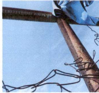
Foto1: SUSTITUCION DE TUBO HG Y MALLA GALVANIZADA
