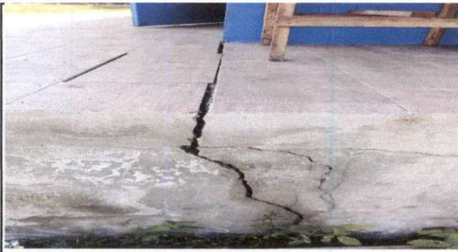
Foto 3: Sustitución de piso cerámico
