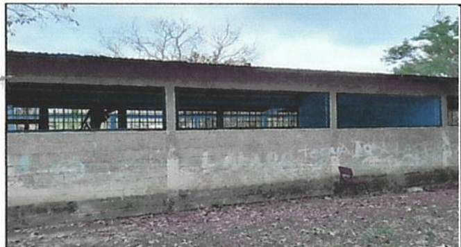
Foto 4: Sustrucción de 3 balcones de metal, lado trasero.
