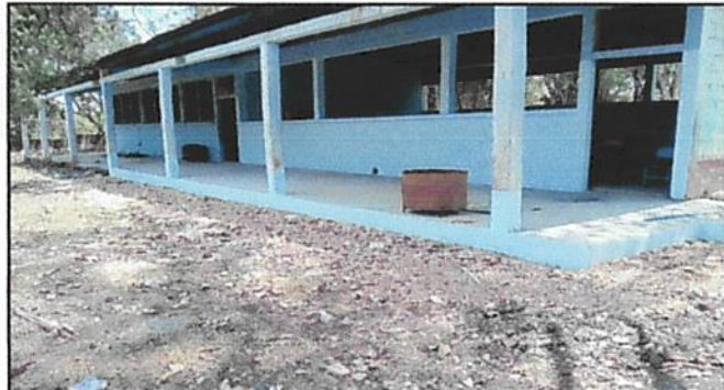
Foto 1: Sustrucción de piso de torta de concreto corredor frontal de aula 1.
