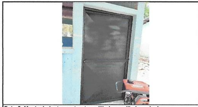
Foto 5: Mantenimiento a estructura (lijado, cepillado, sujeciones, aplicación de pintura)
