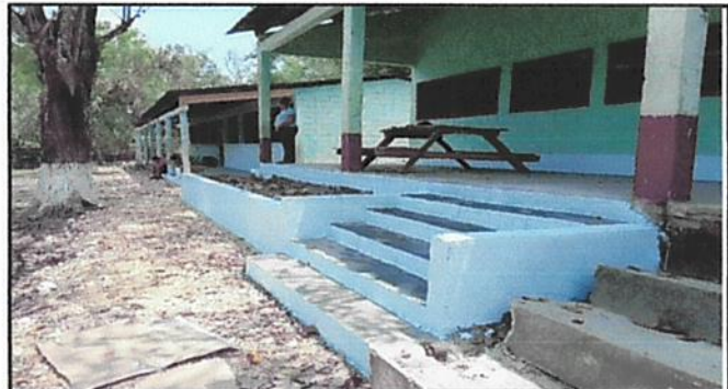
Foto 2: Sustrucción de piso de torta de concreto corredor frontal de aula 2.
