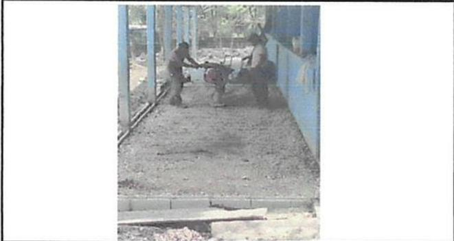
Foto1: Sustitución de piso de torta de concreto corredor frontal de aula 1.
