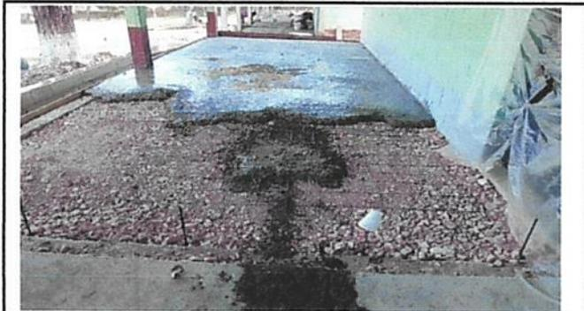
Foto 2: ustitución de piso de torta de concreto corredor frontal de aula 2.
