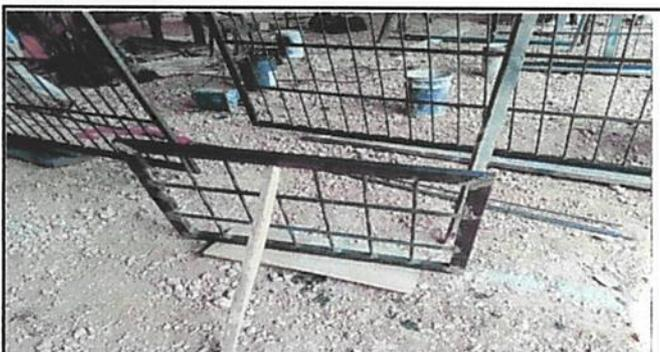
Foto 4: Sustitución de 3 balcones de metal, lado trasero.
