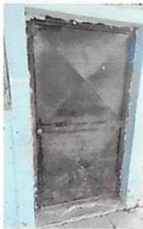
Foto 5: Mantenimiento a estructura (lijado, cepillado, sujeciones, aplicación de pintura)
