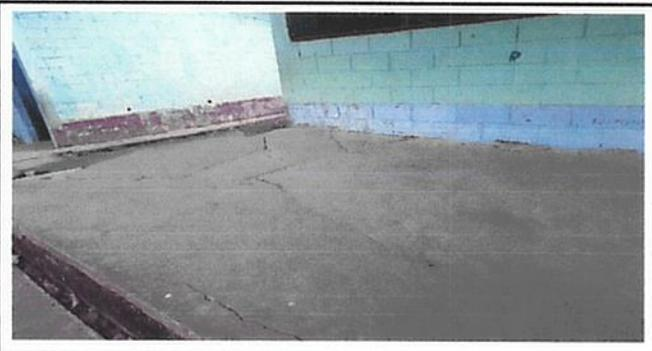
Foto 2: Sustrucción de piso de torta de concreto corredor frontal de aula 2.
