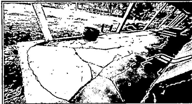
Foto 1: Sustrucción de piso de torta de concreto corredor frontal de aula.
