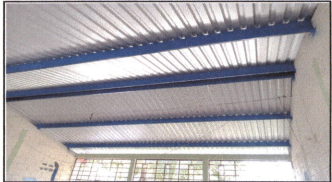
Foto 2: Mantenimiento a estructura de soporte de metal
