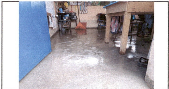
Foto 6: Sustitución de piso de torta de concreto.
