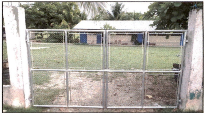
Foto 4: Sustitución de portón.
