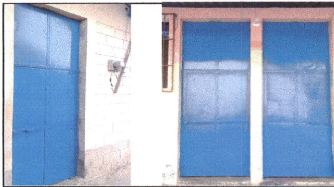
Foto 3: Sustitución de puertas.
