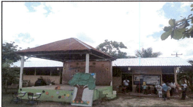
Foto 1: Cubierta de lámina
