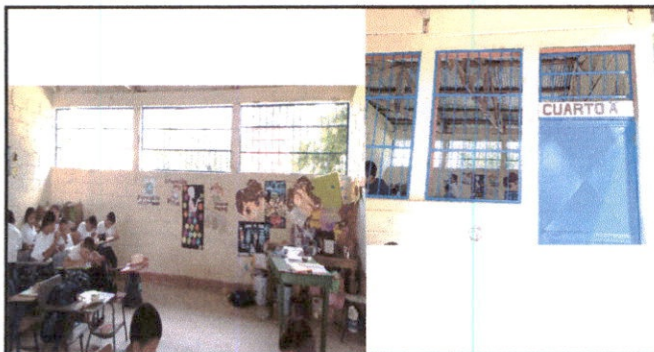
Foto 5: Sustitución de balcones de metal.
