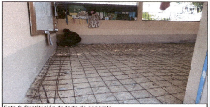
Foto 6: Sustitución de torta de concreto
