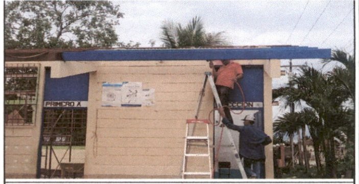
Foto 2: Mantenimiento a estructura de soporte de metal
