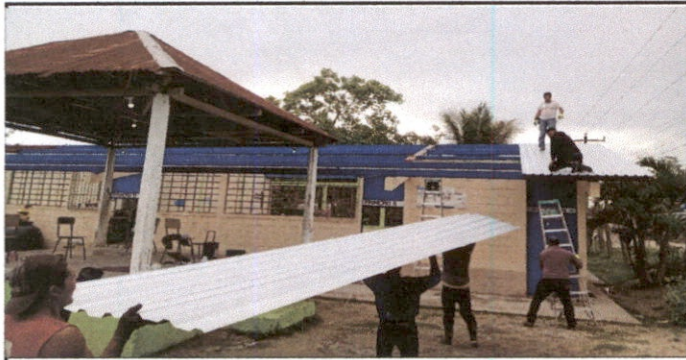
Foto 1: Cambio de cubierta de lámina
