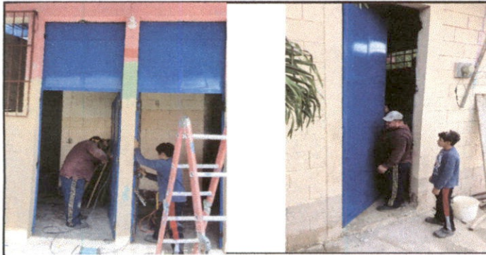
Foto 3: Sustitución de puertas
