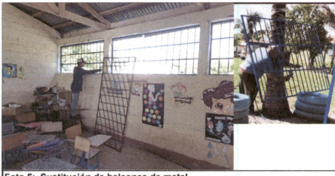
Foto 5: Sustitución de balcones de metal
