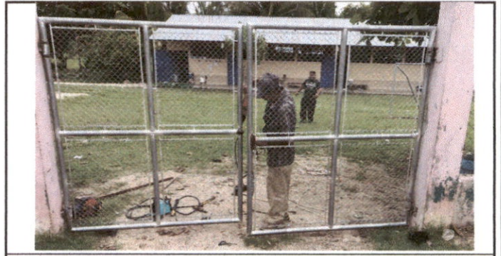
Foto 4: Sustitución de portón.
