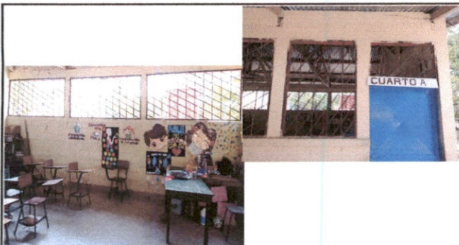
Foto 5: Sustitución de balcones de metal.
