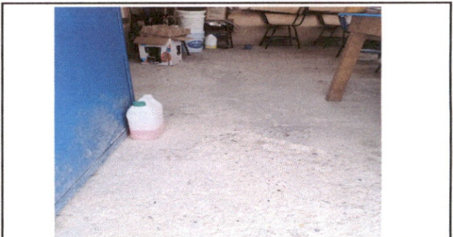
Foto 6: Sustitución de piso de torta de concreto.
