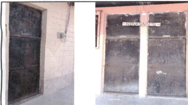
Foto 3: Sustitución de puertas.
