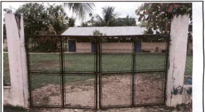
Foto 4: Sustitución de portón
