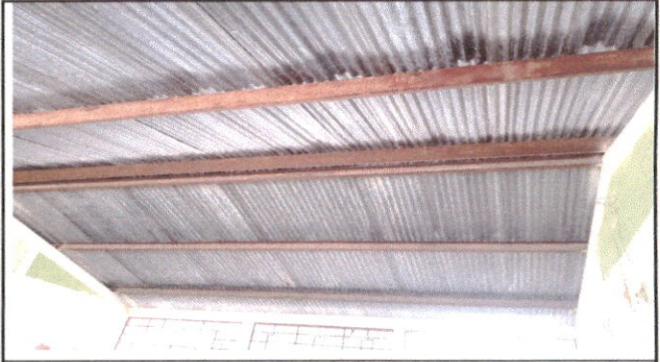
Foto 2: Mantenimiento a estructura de soporte de metal.
