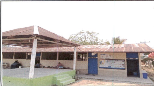
Foto1: Cubierta de lámina
