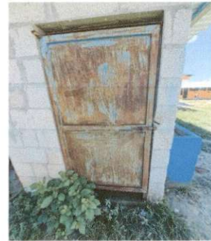
Foto 4: SUSTITUCIÓN DE PUERTAS EN SERVICIOS SANITARIOS
