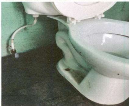
Foto 5: SUSTITUCIÓN DE ACCESORIOS INODORO
