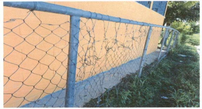
Foto 8: REPARACION DE TUBO HG Y MALLA GALVANIZADA
