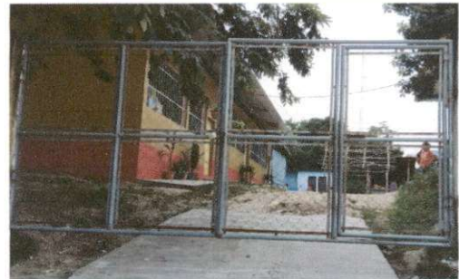
Foto 6: Mantenimiento a portones de metal
