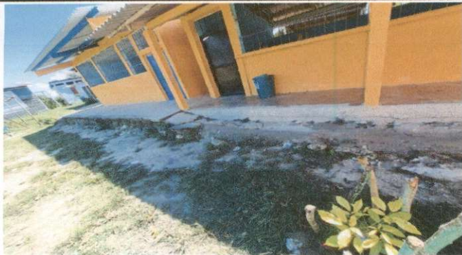
Foto 7: LOSA DE PATIO
