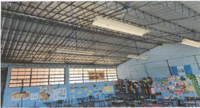
Foto 1: REPARACIÓN DE SISTEMA ELÉCTRICO
