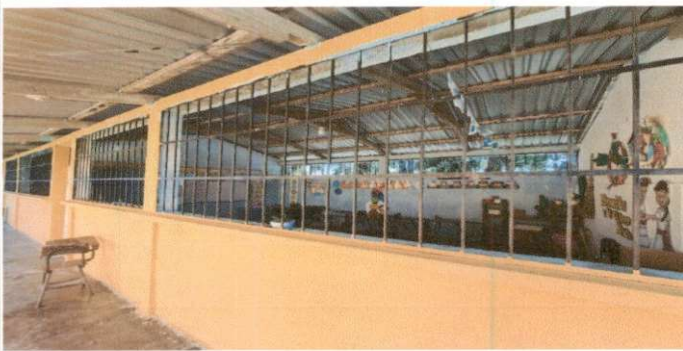
Foto 3: MANTENIMIENTO DE BALCONES DE METAL
