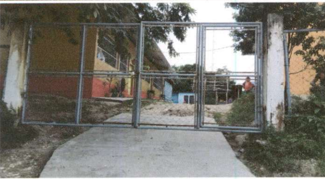
Foto 9: REPELLO EN MUROS
