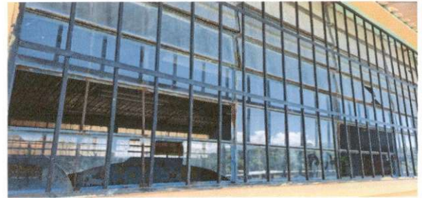
Foto 4: MANTENIMIENTO A ESTRUCTURA(SUJECIÓN DE BALCONES)
