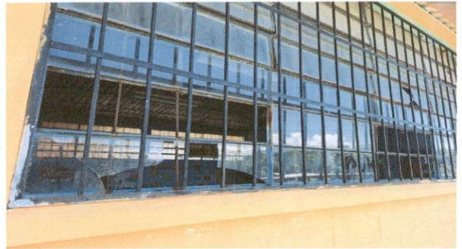
Foto 2: SUSTITUCIÓN DE VIDRIOS
