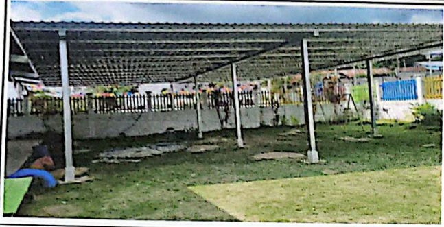
Foto 1: SUSTITUCION DE LAMINA POR LAMINA GALVANIZADA
