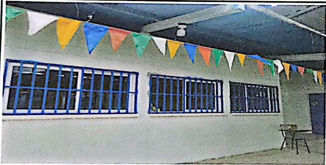
Foto 3: FABRICACION E INSTALACION DE BALCONES DE VENTANAS
