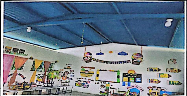
Foto 2: SUSTITUCION DE SISTEMA ELECTRICO PRINCIPAL
