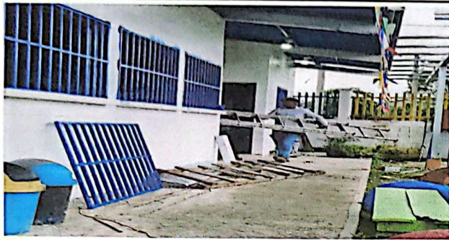
Foto1: Sustitucion e Instalacion del sistema electrico principal
