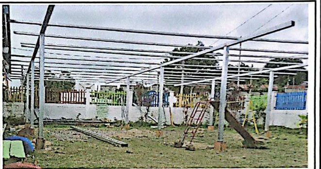
Foto 4: Sustitucion de lamina por lamina galvanizada aluzinc calibre 16
