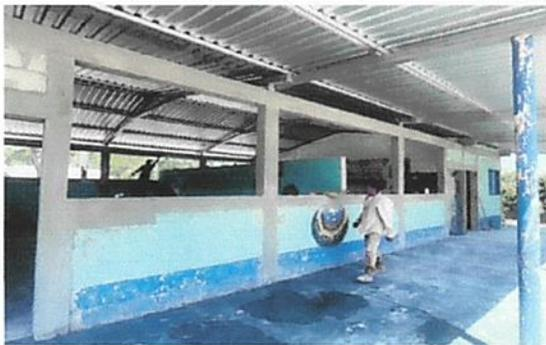
Foto 3: Soleras y columnas intermedias terminadas.
