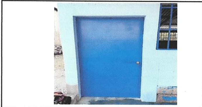
Foto 1: Sustrucción de puuerta de madera por metal terminado.
