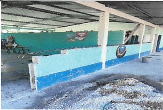
Foto 3: Sustrucción y Reparación de Soleras Intermedias.
