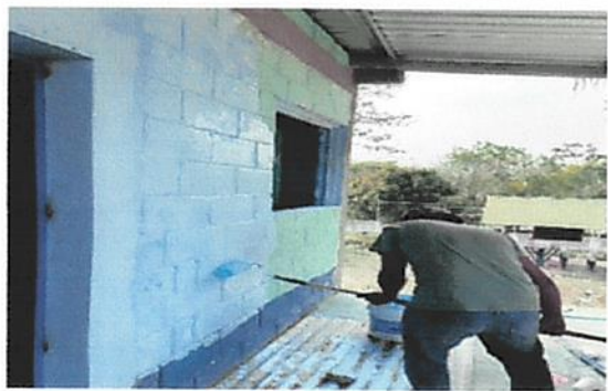
Foto 2: Sustrucción de Pintura de muros exteriores.
