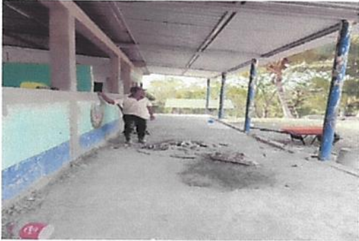
Foto 1: Sustrucción de piso.
