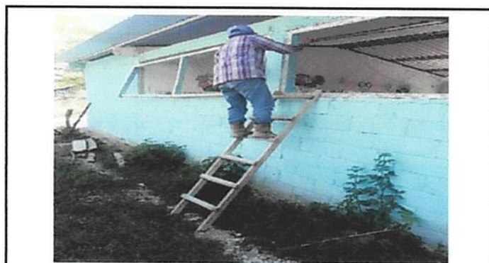
Foto 4: Sustitución de ventanas de las aulas, parte de atrás.
