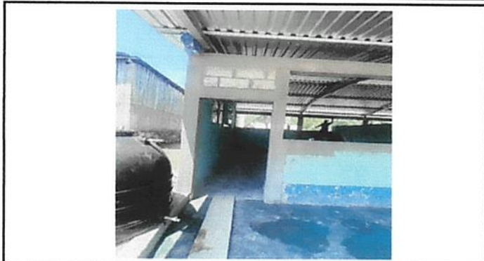
Foto 1: Fotografía de sustitución de puerta de madera.
