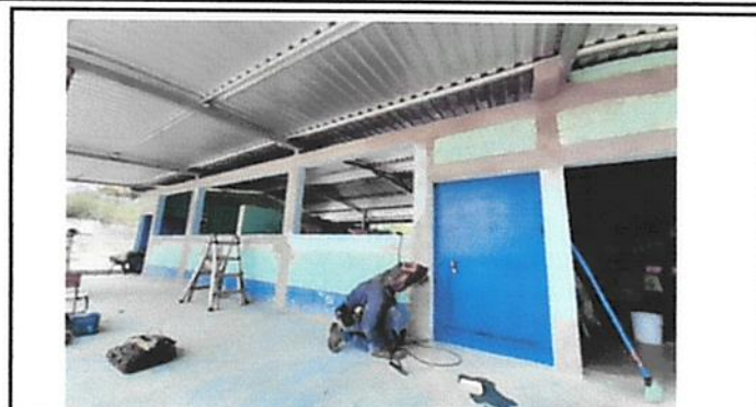
Foto 2: Fotografía de sustitución de puerta 2 y 3 de madera
