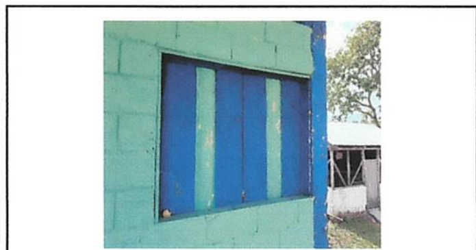
Foto 3: Sustitución o Colocación de balcón en la ventana.
