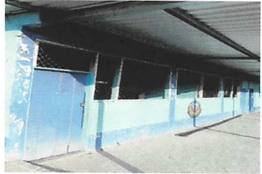
Foto 2: sustitución de pintura de muros exteriores.
