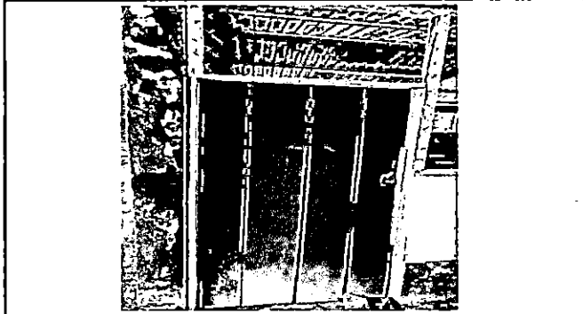
Foto 1: Fotografía de puerta de madera 1 que se encuentra en mal estado y necesita ser sustituida.
