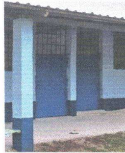
Foto 2: Finalización de las puertas de metal.
