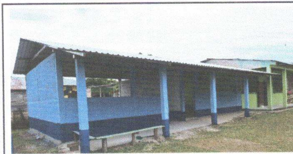
Foto 5: Finalización de mejoramiento de las paredes de las aulas.
