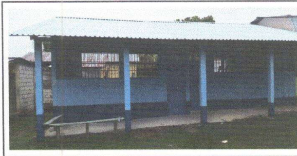
Foto 6: Visualización de la finalización de las aulas, con todas sus mejoras en paredes, puertas y techo.
