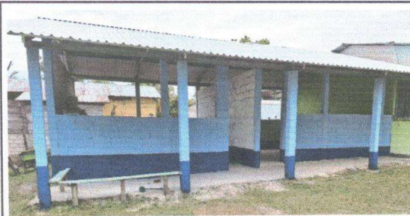
Foto 3: Finalización de estructura de techo de metal.
