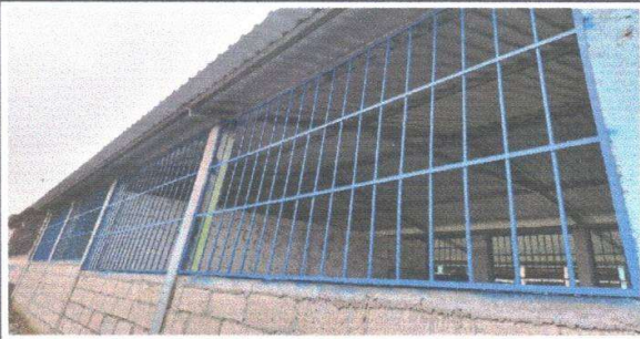
Foto 1: Finalización de la instalación de balcones alrededor de las aulas.
