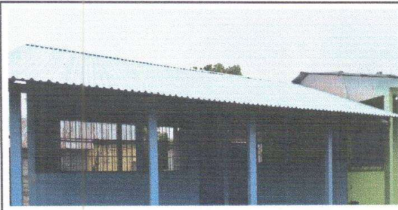
Foto 4: Finalización de la instalación de estructura de techo de lámina troqueada.
