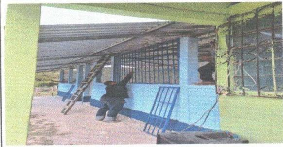
Foto 1: Sustitución de balcones de metal
