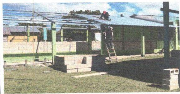
Foto 4: Sustitución de lámina, por lámina troquelada.
