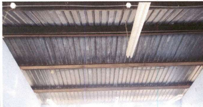
Foto 3: Sustrucción de estructura de soporte de metal, por metal
