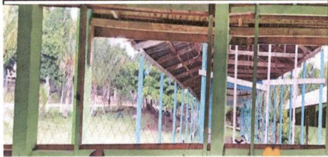
Foto 1: Sustrucción de balcones de metal
