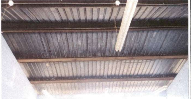
Foto 4: Sustrucción de lámina, por lámina troquelada aluzinc calibre 26
